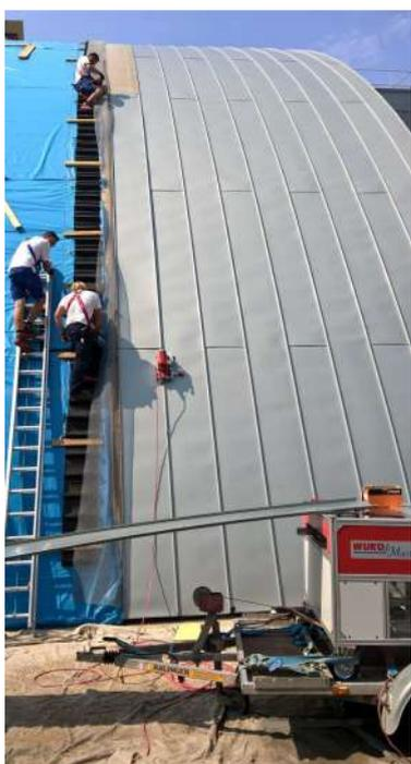
Foto: l'utilizzo della profilatrice WUKO Master e dell'aggraffatrice WUKO Sprinter al sito di costruzione del Museo di Bassa Austria a St. Pölten da parte della ditta austriaca Mössler Dach GmbH.
